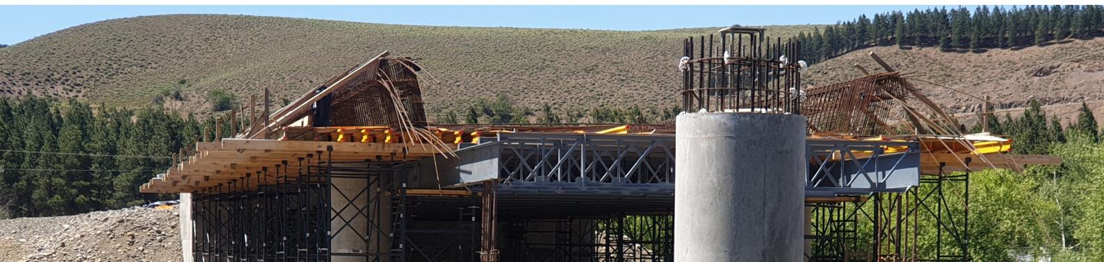
Desarrollo y construcción de puente distribuidor de tránsito de 5 carriles con una solución de tablero de espesor constante con elementos alivianadores, fundado sobre pilas con apoyos tipo pote y pote guiado.
